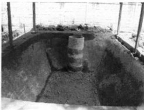
**Gambar 6** . Landfill sebelum dipasang geomembran
