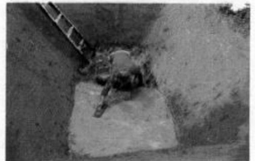
**Gambar 5** . Sistem pelapisan dan kemiringan landfill
